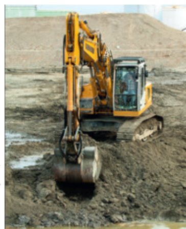
Excavation des terres sur un ancien site de stockage d'hydrocarbures en cours de dépollution (Bas-Rhin).
